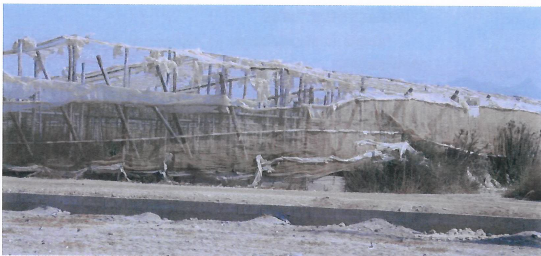
Foto nº 3: Invernaderos en la finca Nº 5. (estructura de madera)
