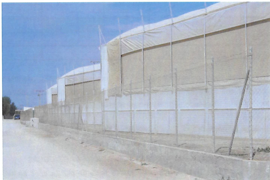
Foto nº 2: Invernaderos en la finca Nº 1. (estructura metálica)
