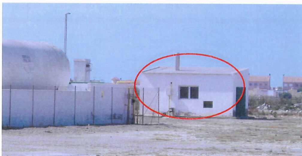
Foto nº 5: almacén o cuarto de instalaciones, en la finca Nº 3. (ya no existe)
