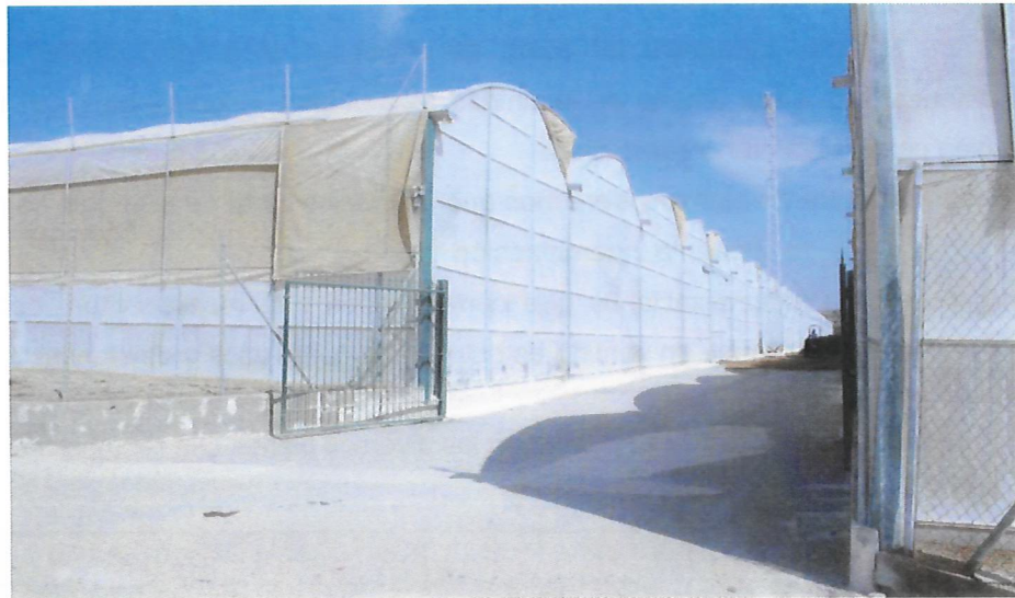
Foto nº 1: Invernaderos en la finca Nº 1. (estructura metálica)
