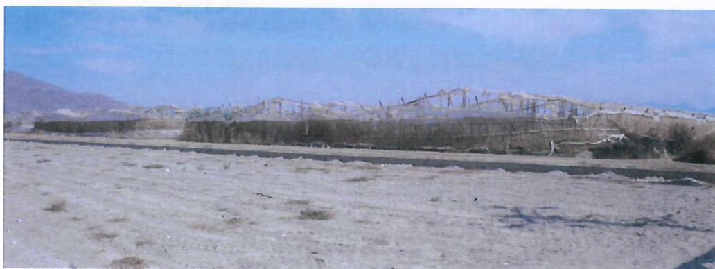
Foto nº 4: Invernaderos en la finca Nº 5. (estructura de madera)
