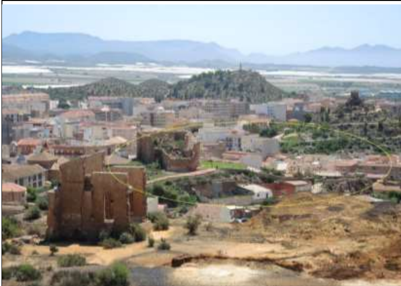
Vistas del PECHA desde la zona minera al oeste
