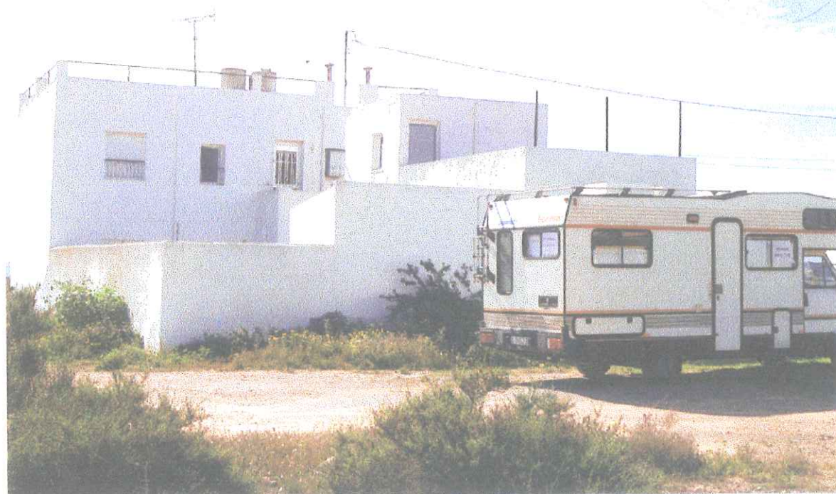
VIVIENDA EN BUEN ESTADO, PROPIEDAD DE D. FRANCISCO GARCIA HERNANDEZ - PARCELA 30 - POLIGONO 13.
