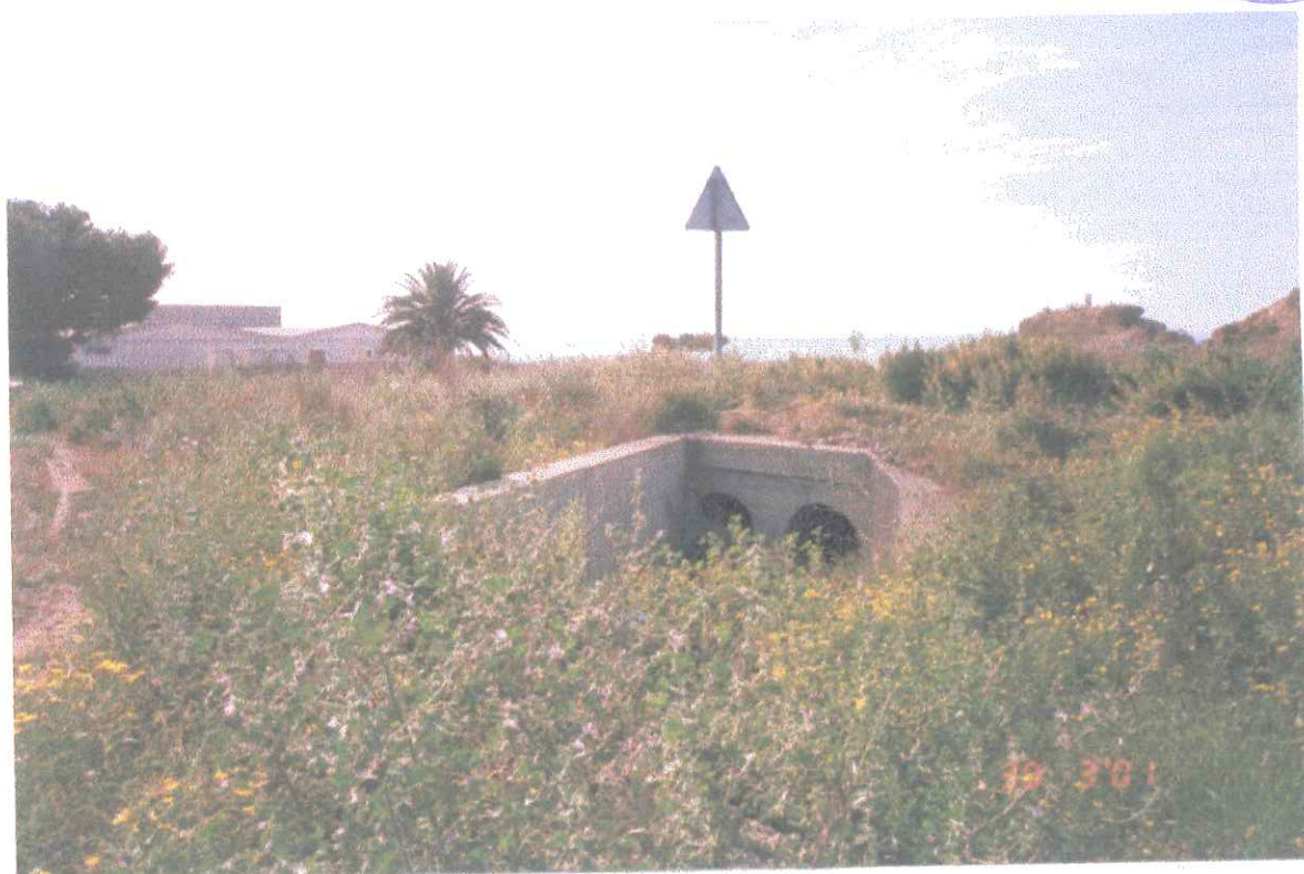
PASO DE AGUAS BAJO LA CARRETERA E-22.
