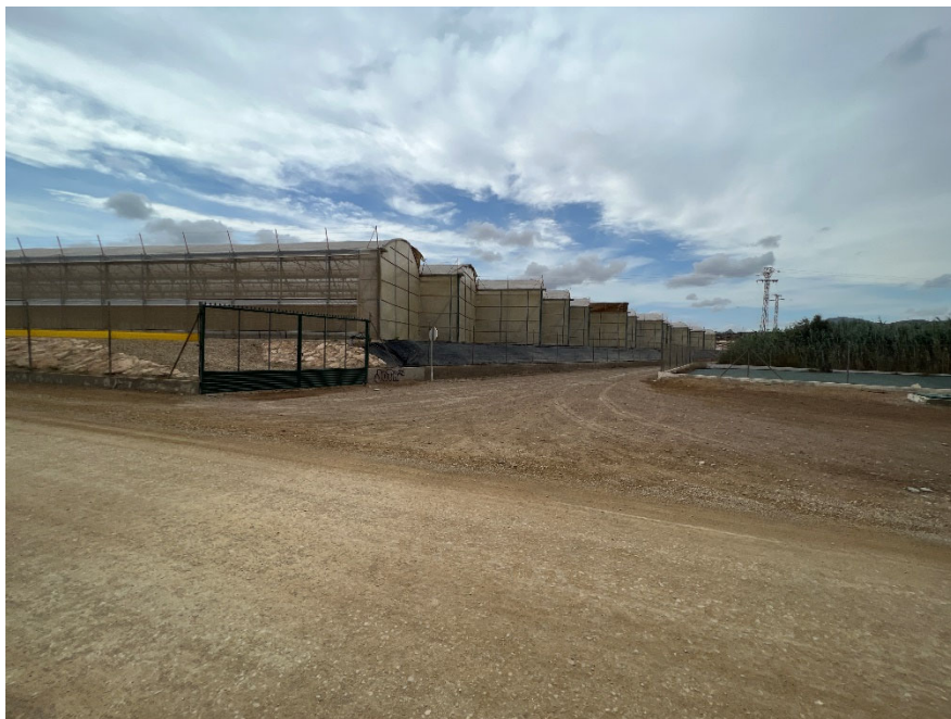
Cruce entre Camino del Vivero con camino secundario de acceso al Área.
