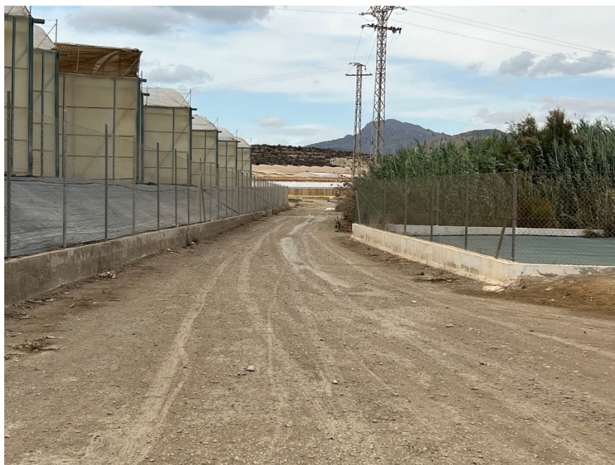
Sentido hacia el acceso al Área de autocaravanas.
